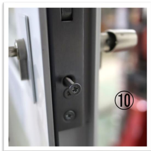
⑩固定ボルトを締めていきます。
